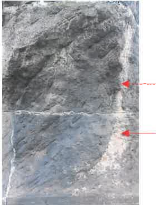
obr. 4 tmavé depozity na povrchu kamene (nahore) a tvorba síranových krust v důsledku vymývání karbonátových složek z malty ve spáře (dole) Bloky PA/8 a PB/3
