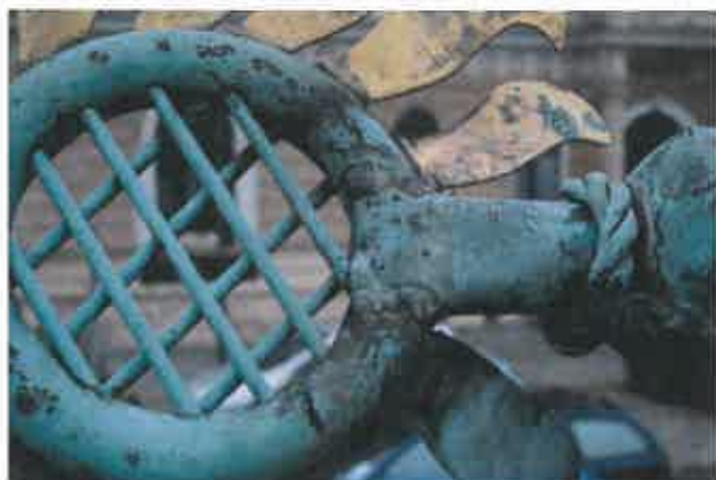
Ukázka nevzhledného cínování, degradace zlacení a pokřivených detailů (třásně)
