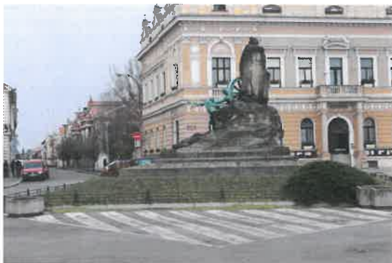
obr. 1 Pomník Prokopa Holého, Husovo náměstí, pohled od jihovýchodu
