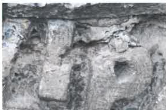
obr. 5 zvětrávání jílovitých vrstev v kameni
