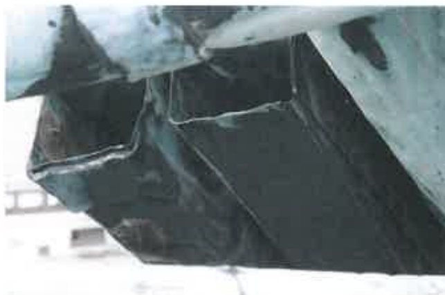
Ukázka nevzhledného cínování, degradace zlacení a pokřivených detailů (třásně)
