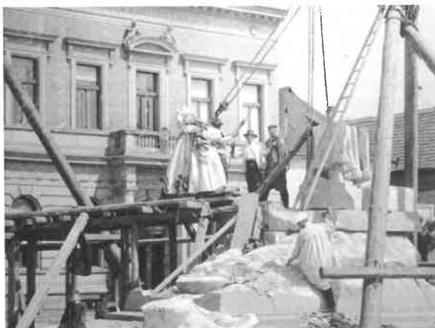
Stavba pomníku a dokončování podstavce přímo na místě, archiv Podlipanského muzea
