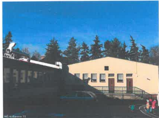
Obr. 10 JV štít pavilonu D, SV průčelí pavilonu E
