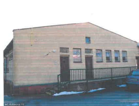
Obr. 06 SZ štít pavilonu C
