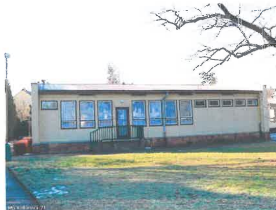
Obr. 05 SV průčelí pavilonu C
