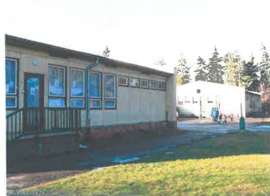
Obr. 12 SV průčelí pavilonu C
