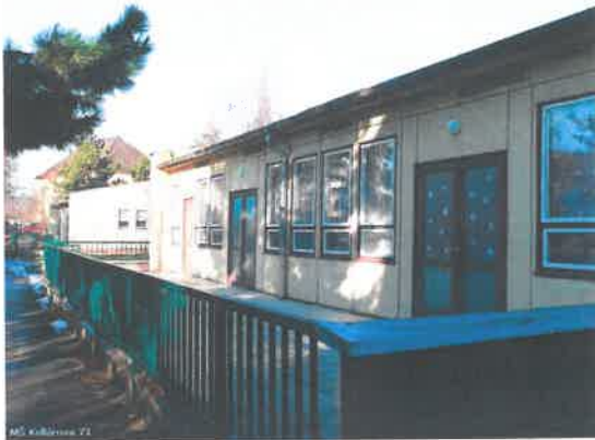
Obr. 07 JZ průčelí pavilonu A
