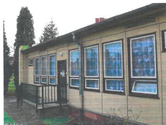
Obr. 03 SV průčelí pavilonu A
