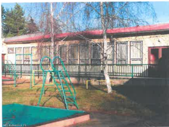
Obr. 08 JZ průčelí pavilonu B
