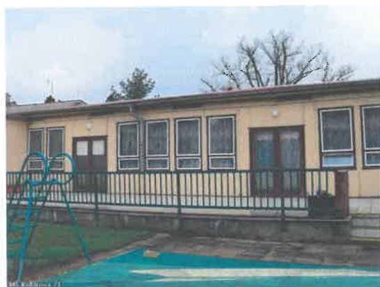
Obr. 02 JZ průčelí pavilonu C
