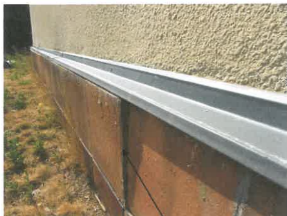
Pavilon B - fasáda
