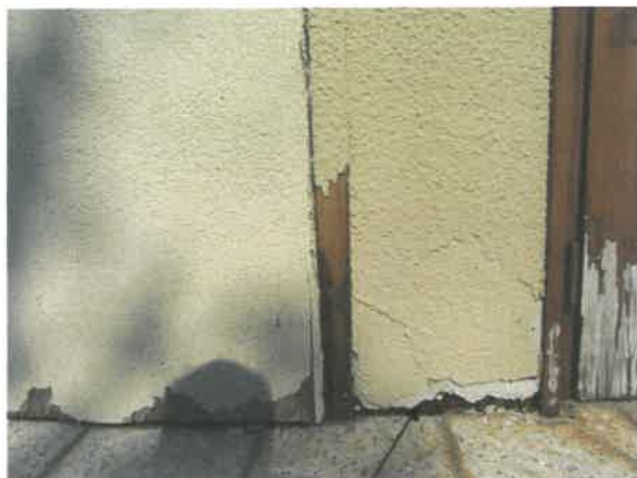
Pavilon B - fasáda
