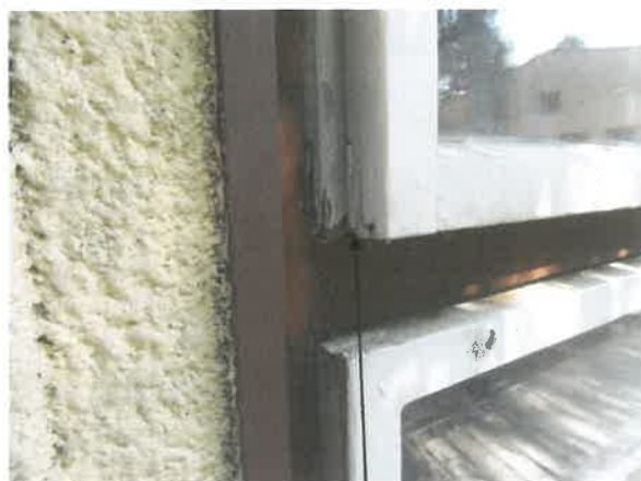
Pavilon B - fasáda
