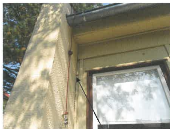
Pavilon B - fasáda
