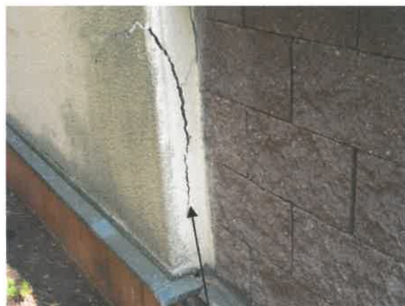
Pavilon B - fasáda
