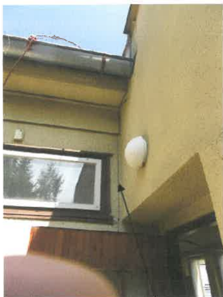
Pavilon A – fasáda
