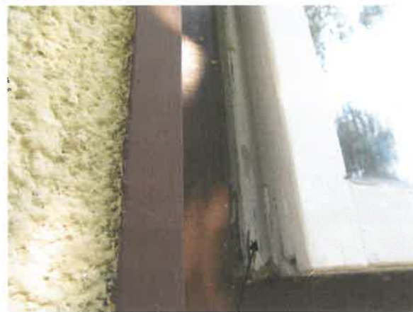
Pavilon B - fasáda
