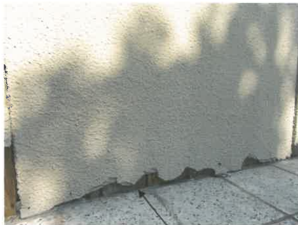
Pavilon B - fasáda
