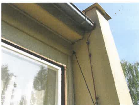
Pavilon B - fasáda
