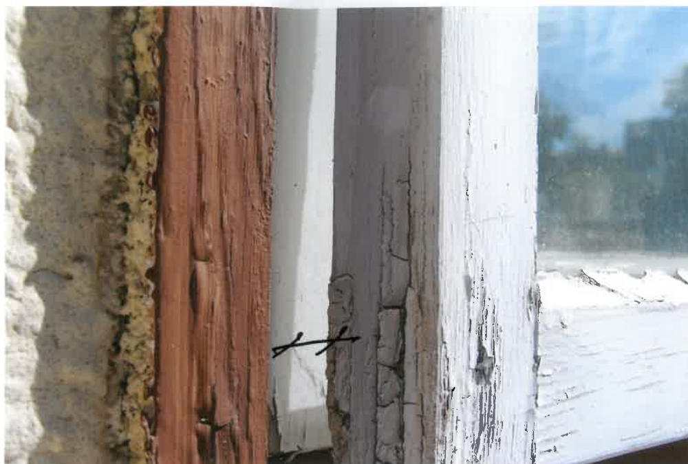
foto č. 9 - rozestup dvojokna v objektu C
