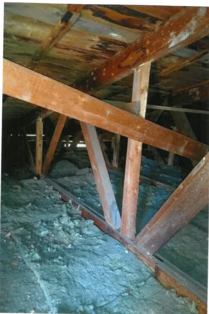
foto č. 5- poškození podbití v objektu C voštinovou hnilobou
