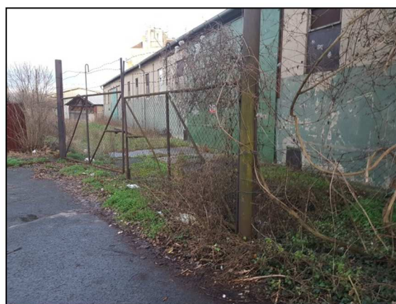
Obr. 4 – Vjezd č. 2 ze západní části areálu ZZN ul. Kollárova
